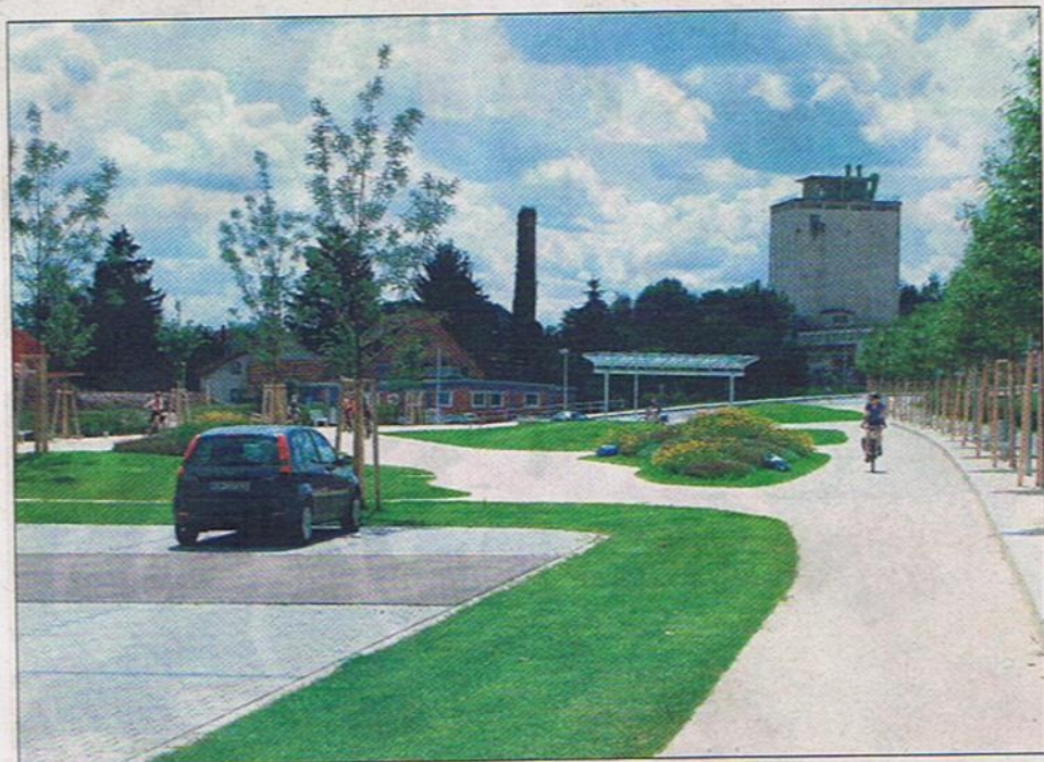
Ein Radweg in Kupferzell auf einer ehemaligen Bahntrasse.
